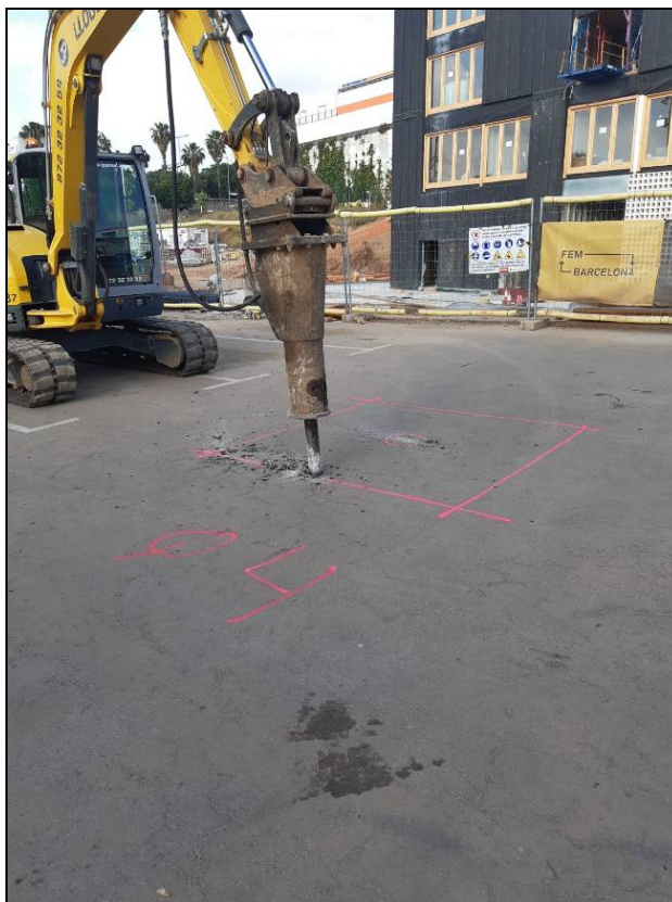
Fotografia 2: Trencament de l'asfalt per fer les cales prèvies a l'inici de les obres.
