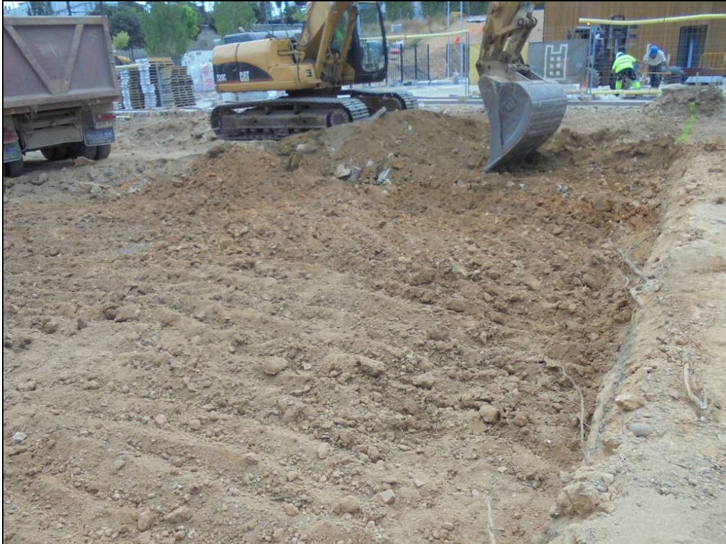
Fotografia 10: Treballs de rebaix general fins assolir la cota dels encepats.
