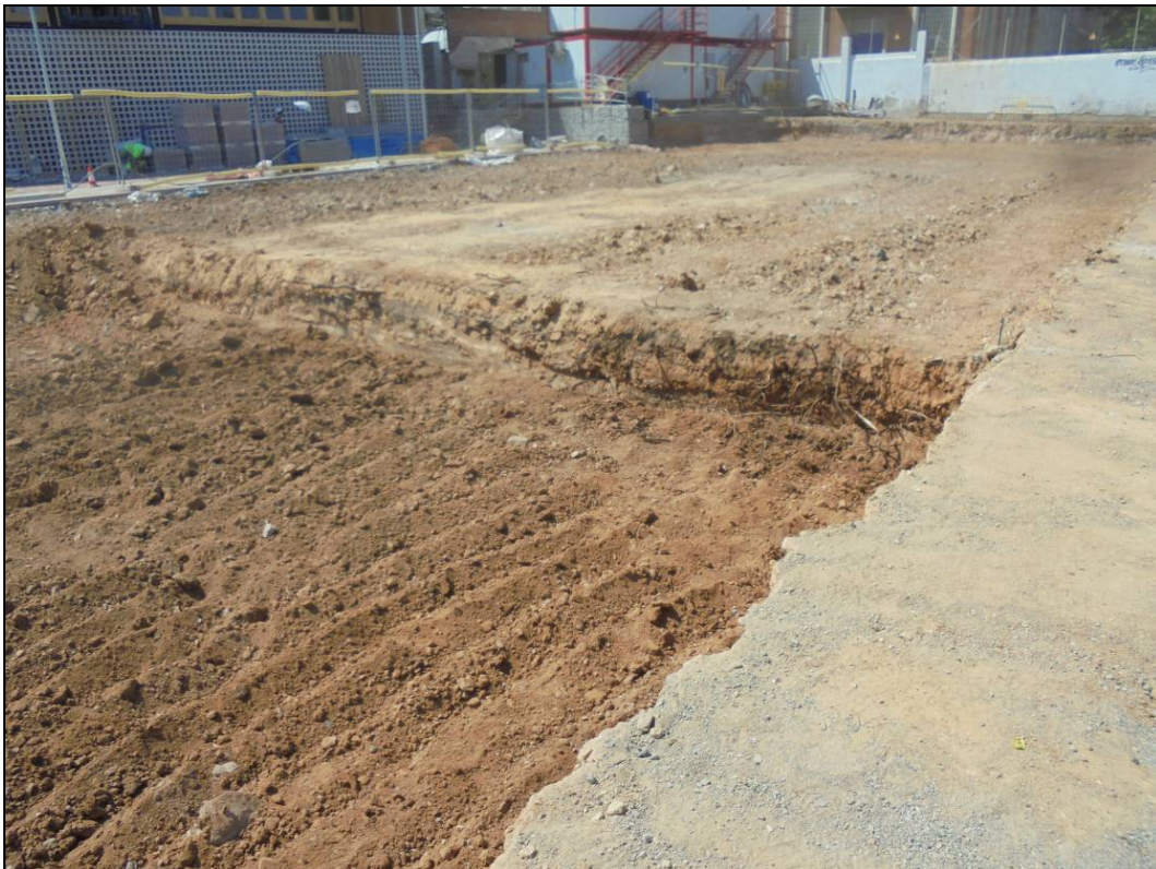
Fotografia 8: Rebaix general del terreny fins les cotes 32,20 i 31,70 m snm.
