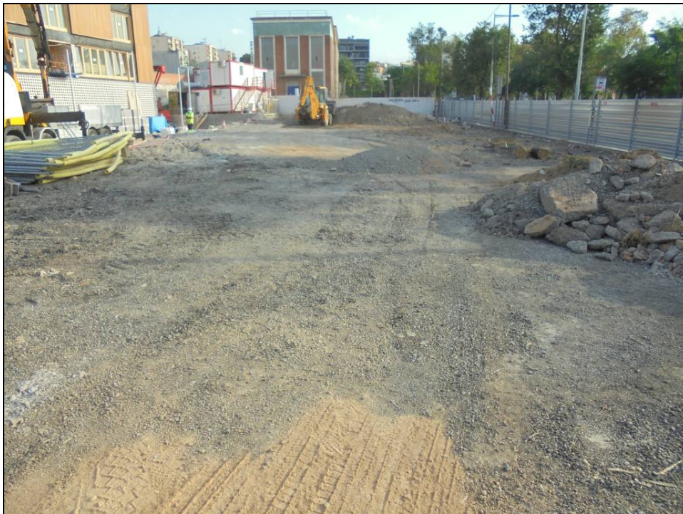
Fotografia 1: Vista general del solar, presa des de l'extrem sud.
