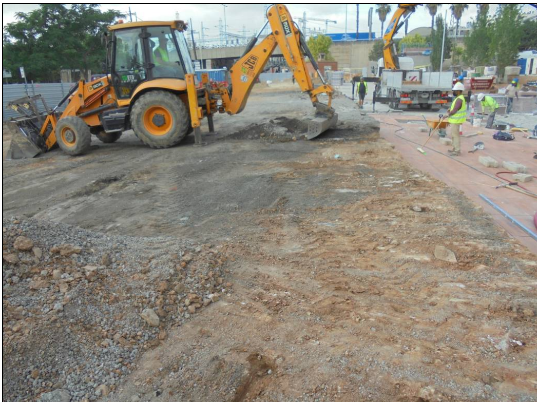
Fotografia 6: Retirada de l'asfalt i terres contaminades, uns 40 cm de potència.
