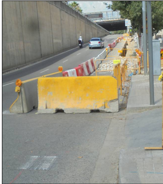
Fotografia 17: Ubicació de rasa de servei oberta fora del solar, a l'asfalt de la Via Favència.
