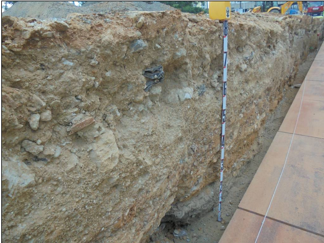
Fotografia 5: Estrat d'aportació antròpica deixat a la vista en el tall de l'obra, a la banda oest del solar.
