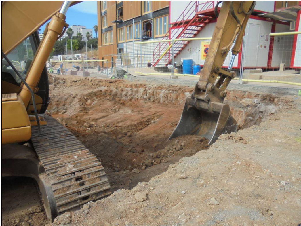
Fotografia 9: Treballs de rebaix general fins assolir la cota dels encepats.
