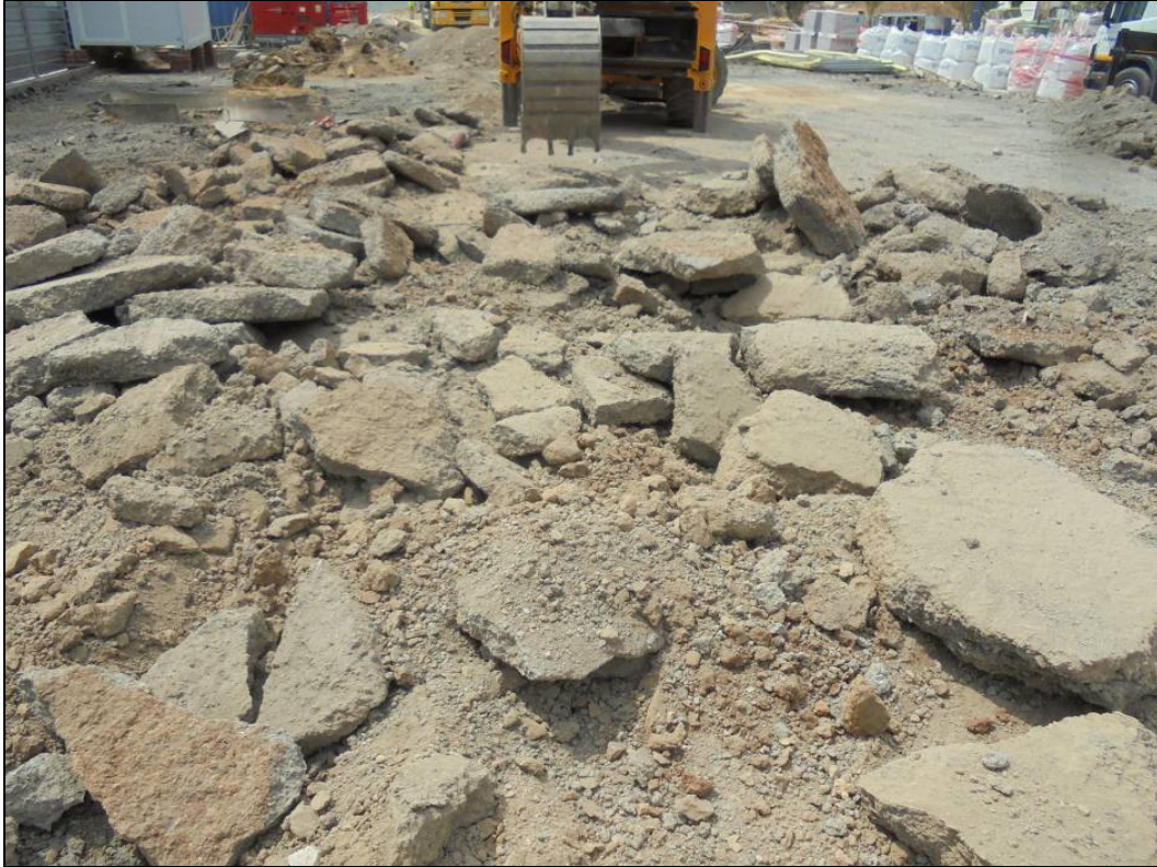
Fotografia 7: Retirada de l'asfalt i terres contaminades, uns 40 cm de potència.
