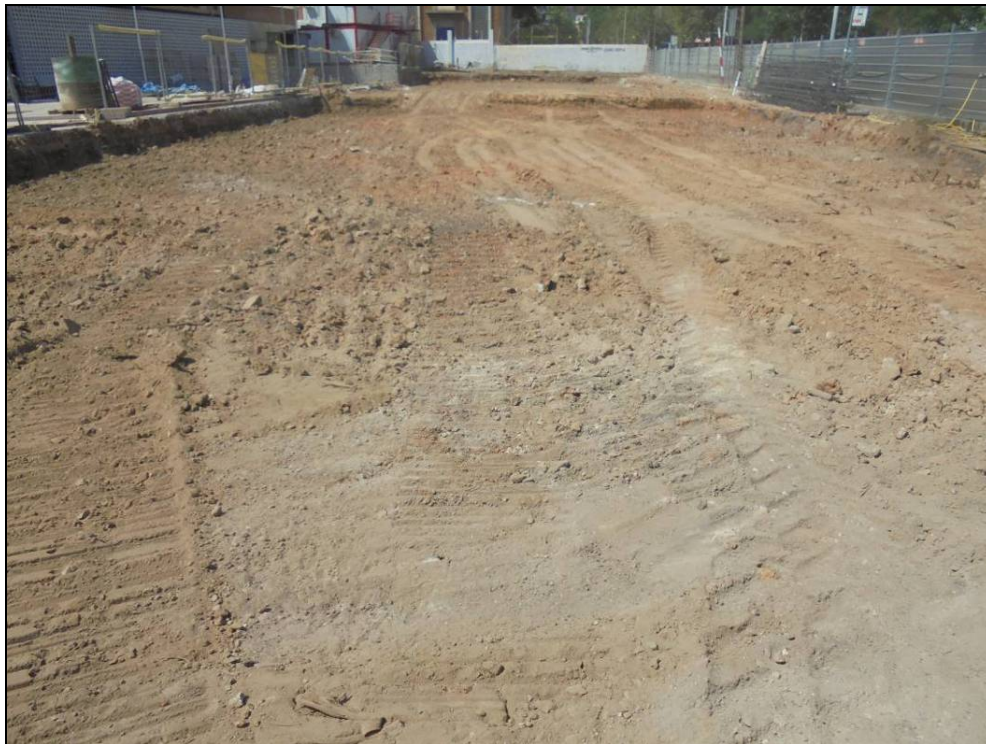
Fotografia 11: Rebaix general finalitzat. Vista general de la plataforma pels encepats.
